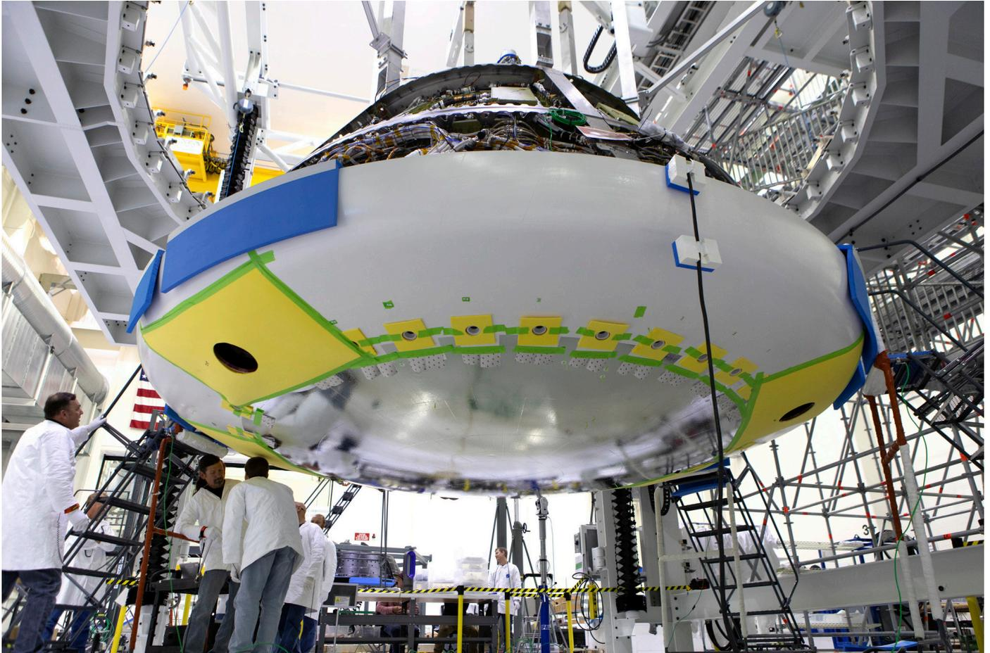
Instalación del escudo térmico en el módulo de tripulación de la nave espacial Orión de la NASA en el Centro Espacial Kennedy en Florida el 25 de julio de 2018. (NASA/Kim Shiftett)
