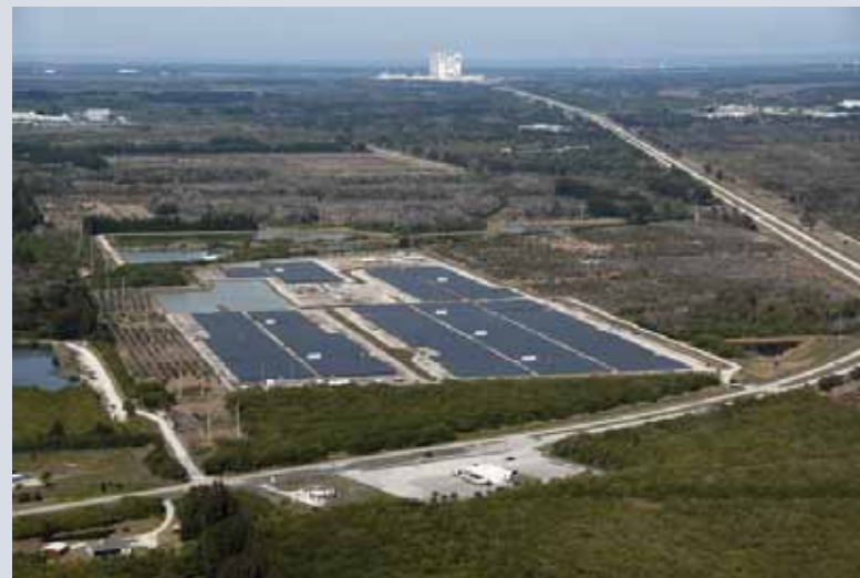
FPL 10 MW Solar Power Site
